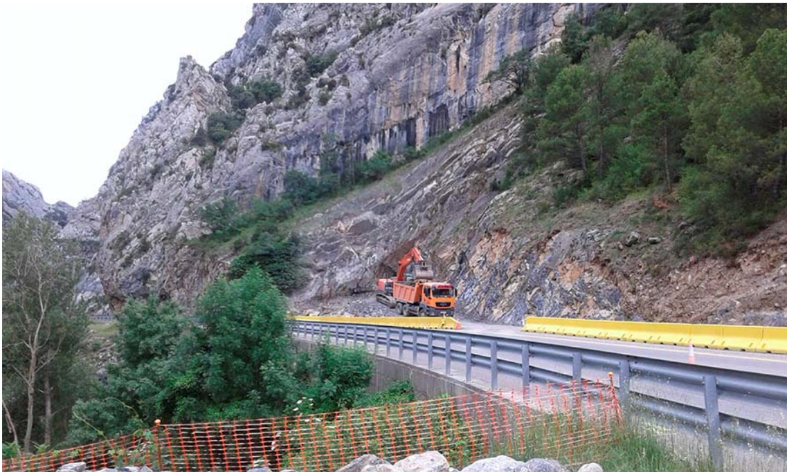
Imatge de l'inici, avui, de les tasques de perforació del túnel.
